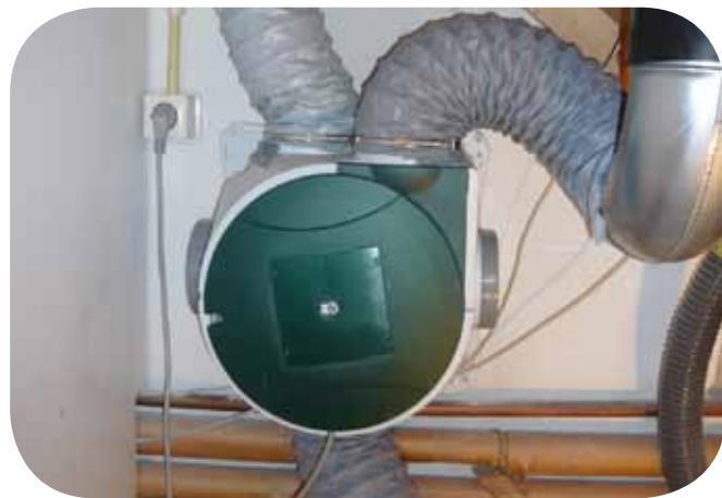
Standaard mechanisch ventilatiesysteem
