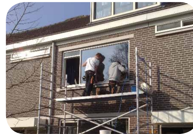
Aanbrengen van ventilatieroosters
